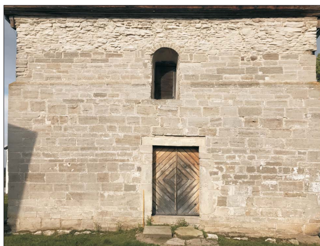
Ryc. 13. Ściana zachodnia kościoła pw. Narodzenia NPM w Sulisławicach
