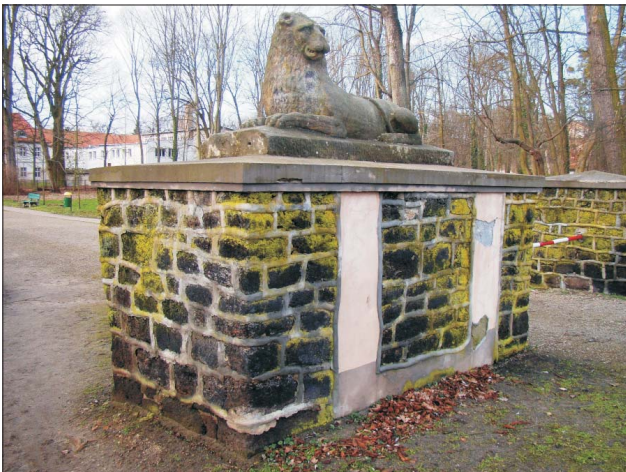
Ryc. 20. Pozostałości Bramy Pokoju koło pałacu rodziny von Maltzan w Miliczu
