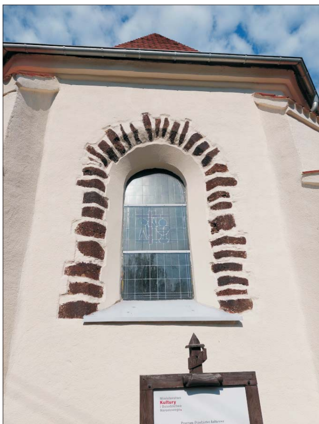
Ryc. 6. Kościół pw. św. Marcina w Świdnicy koło Zielonej Góry. Okno prezbiterium ozdobione bloczkami rudy darniowej Fig. 6. St Martin's Church in Świdnica near Zielona Góra. Window of the presbytery decorated with blocks of bog ore
