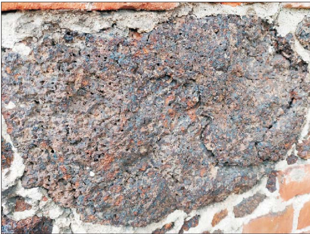
Ryc. 2. Blok rudy darniowej ze śladami złuszczeń mrozowych – zespół pałacowo-parkowy gen. Klickiego w Łowiczu Fig. 2. Bog ore block with traces of frost exfoliation – palace and park complex of Gen. Klicki in Łowicz city
