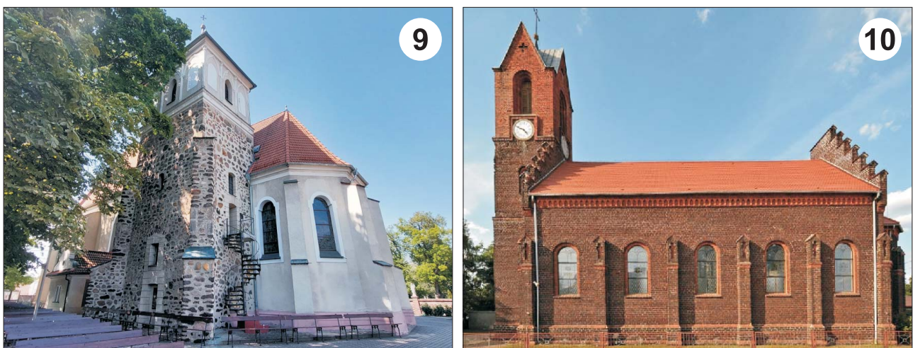
Ryc. 9. Kościół pw. św. Jadwigi we Wrocławiu–Leśnicy Fig. 9 St. Hedwig's Church in Wrocław-Leśnica
