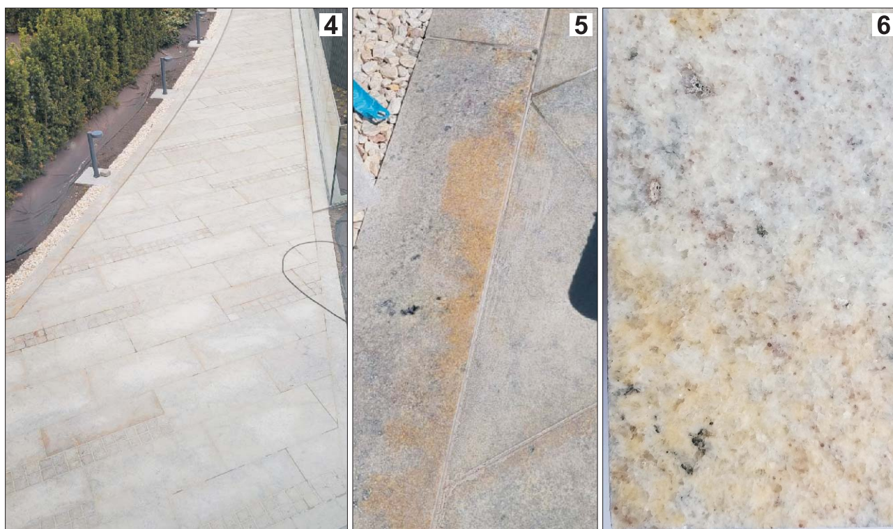
Ryc. 4. Fragment nawierzchni chodnika wykonanej z płyt granitu Delicia White
