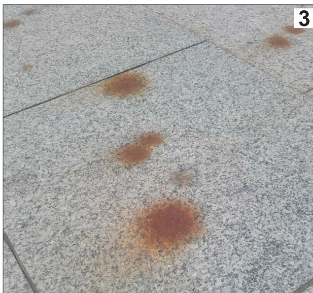
Ryc. 2. Fragment nawierzchni dziedzińca wykonanej z płyt granitu strzegomskiego. Widoczne są rdzawe plamy na powierzchni płyt Fig. 2. Part of the courtyard paving made of Strzegom granite slabs with visible rusty stains in the surface
