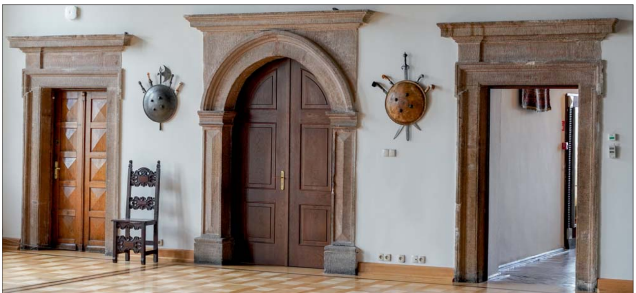
Ryc. 27. Trzy portale w południowej ścianie sieni górnej wykonane prawdopodobnie z piaskowca retu wydobywanego na Górze Baranowskiej (dawny kamieniołom Włochy ) Fig. 27. Three portals in the southern wall of the upper hall, probably made of the Röt sandstone from the Baranowska Hill (old Włochy quarry)
