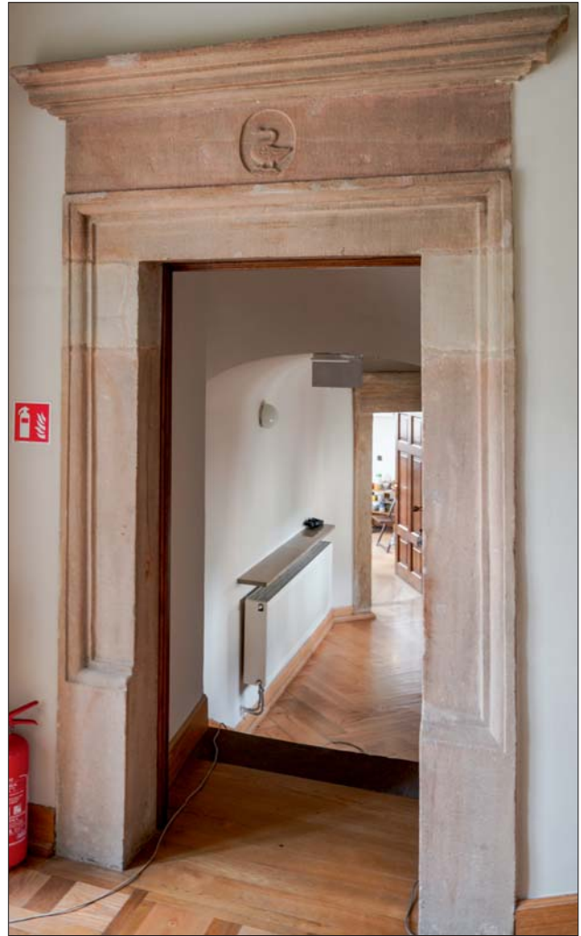
Ryc. 28. Oryginalny portal z herbem Łabędź w starej kaplicy z piaskowca dolnotriasowego z wyraźnymi uzupełnieniami z jasnoróżowego piaskowca Włochy Fig. 28. The original portal with the Swan coat of arms in the old chapel, made of Lower Triassic sandstone with distinct additions made of light pink Włochy sandstone
