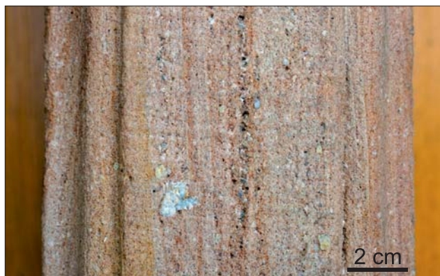
Ryc. 15. Fragment obramienia okna w loggii ogrodowej, wykonanego z piaskowca różnoziarnistego, miejscami zlepionego Fig. 15. Part of the window frame in the garden loggia, made of variously grained, locally conglomeratic sandstone
