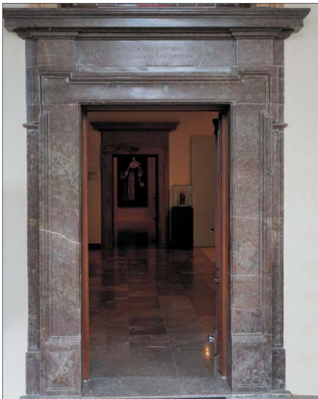
Ryc. 6. Portal z wapienia bolechowickiego w loggii frontowej okalający wejście do sieni dolnej
