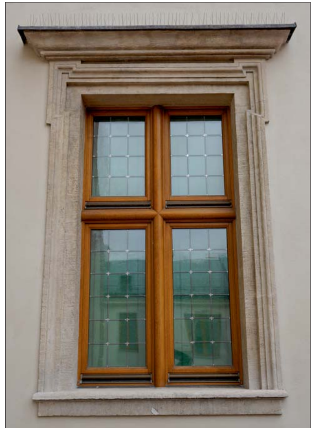
Ryc. 29. Obramowanie okna w południowej elewacji pałacu wykonane z wapienia pińczowskiego. Pod parapetem widoczny biały fragment muszli małża pecten
