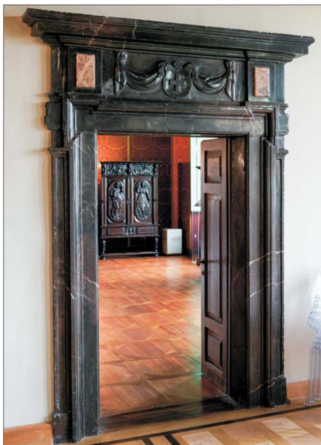
Ryc. 24. Oryginalny portal w ścianie południowej izby stołowej górnej wykonany z wapienia dębickiego z wstawkami z różanki zelejowskiej
