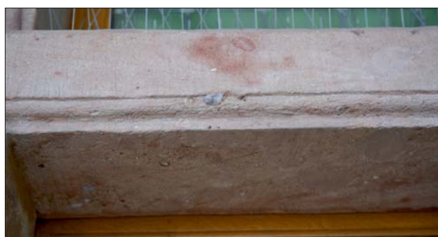
Ryc. 14. Fragment belki okiennej w loggii ogrodowej, wykonanej prawdopodobnie z piaskowca gałęzickiego, zawierającego różnej wielkości otoczki kwarcu
