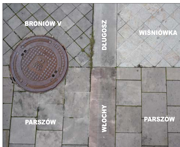
Ryc. 32. Różne rodzaje piaskowców na dziedzińcu głównym: dolnojurajskie piaskowce Broniów i Długosz , piaskowiec Włochy dolnego retu, piaskowiec Parszów górnego retu, górnokambryjski piaskowiec kwarcytowy Wiśniówka
