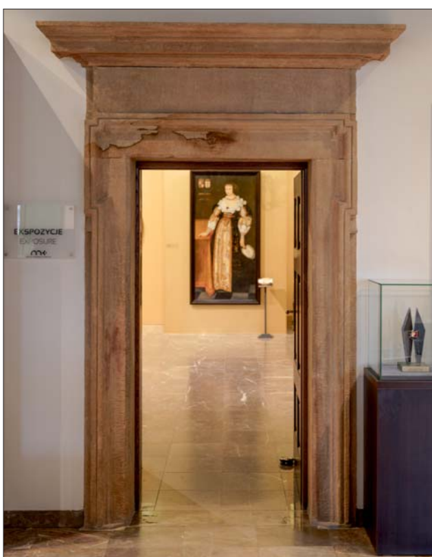
Ryc. 9. Portal w sieni dolnej w przejściu do izby stołowej dolnej, wykonany z piaskowca dolnego triasu
