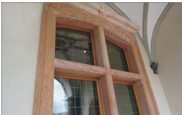
Ryc. 7. Obramowanie okna w loggii frontowej pałacu wykonane z piaskowca dolnego triasu
