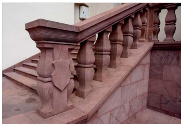
Ryc. 33. Współczesne schody, tralki i poręcze z piaskowca dolnotriasowego Kopulak na dziedzińcu południowym
