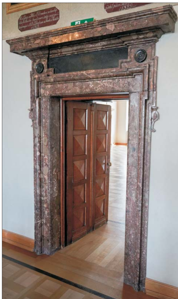
Ryc. 25. Portal w ścianie wschodniej izby stołowej górnej ze zlepieńca zygmuntońskiego, ze zdobieniami z wapienia dębickiego Fig. 25. Portal in the eastern wall of the upper dining room, made of Zygmuntówka conglomerate with Dębnik limestone decorations
