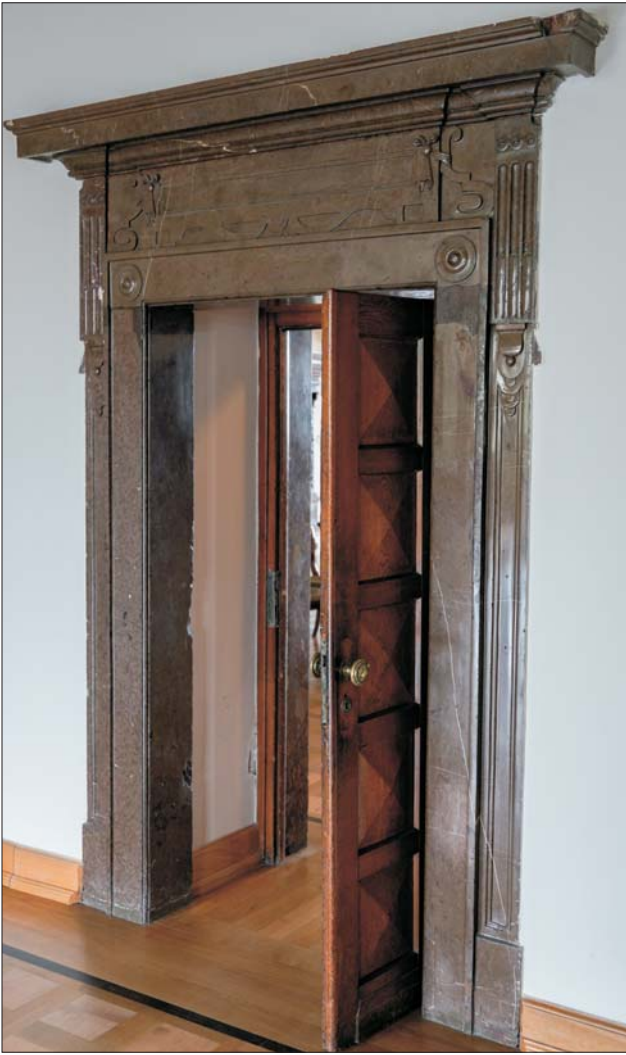
Ryc. 26. Portal w sieni górnej z wapienia bolechowickiego Fig. 26. Portal in the upper hallway, made of Bolechowice limestone
