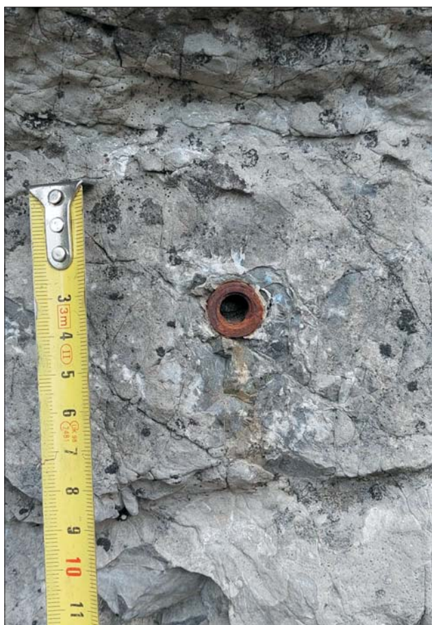
Ryc. 10. Historyczny spit – kotwa do osadzenia punktu asekuracyjnego. Fot. A. Masny
