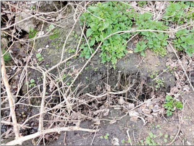
Ryc. 2. Spękania gruntu na terenie ruchów masowych w Dłusku (nr 30-30-055-077336 w bazie SOPO)
