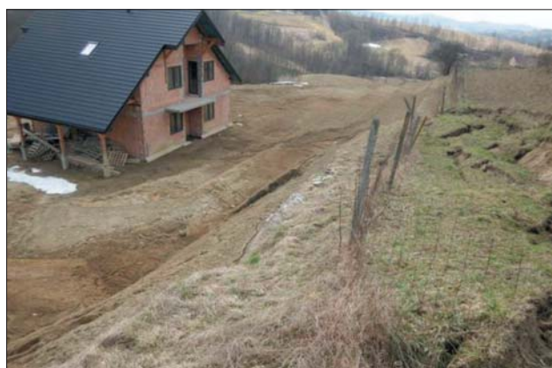
Ryc. 5. Osuwisko w Tuchowie. Fot. E. Rycio
