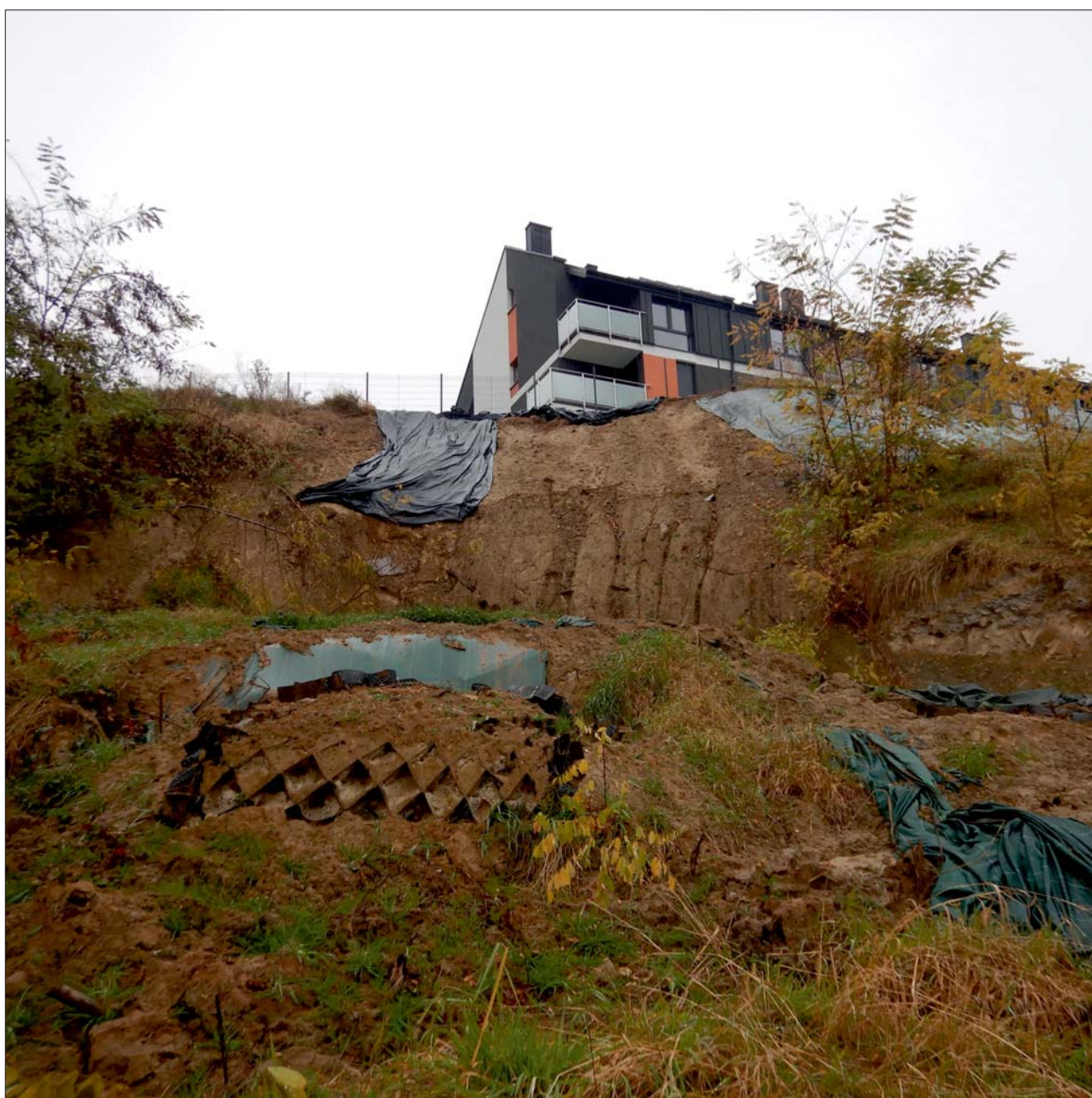
Skarpa główna osuwiska przy ul. Winnickiej w Wieliczce. Fot. S. Kamieniarz, 2.11.2021 r.
