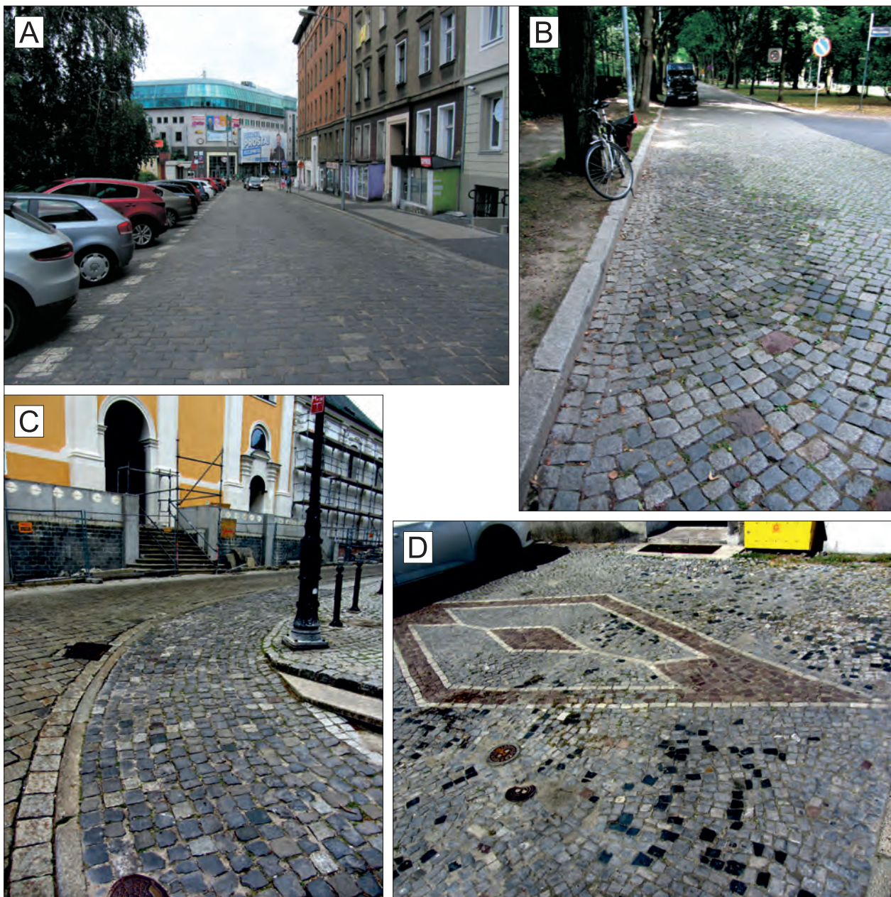
Ryc. 3. Przykłady istniejących nawierzchni wykonanych z eocenu numulitowego: A – jezdnia ulicy Romana Szymańskiego, B – fragment w jezdni ul. Małopolskiej, C – chodnik na ul. Góra Przemysła, D – mozaika na ul. Stanisława Wyspiańskiego, wykonana częściowo z utworów eoceńskich
