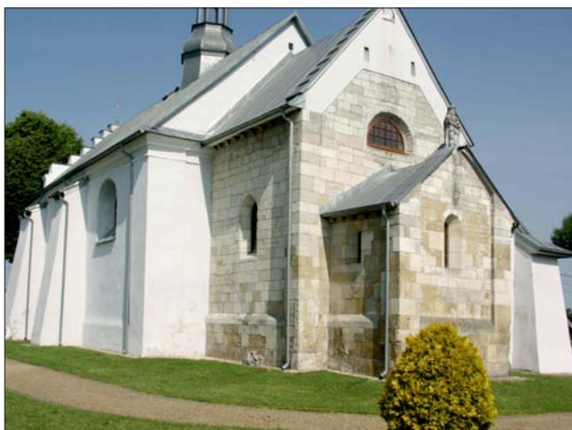
Ryc. 9. Kościół pw. Wniebowzięcia Najświętszej Marii Panny w Mokrsku Dolnym, widok od NE
