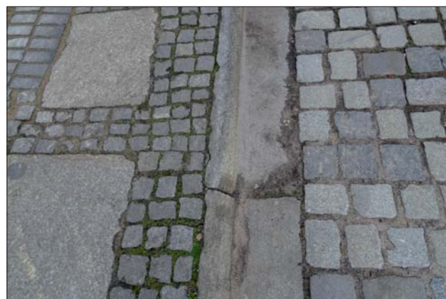
Ryc. 3. Ulica Czartoria – granitowo-gnejsowa kostka rzędowa (po prawej), granitowe ryzsztoki oraz granitowe płyty chodnikowe (po lewej)
