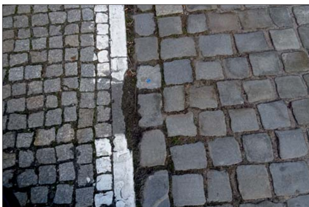
Ryc. 2. Ulica Chwaliszewo – jezdnia pokryta kostką brukową rzędową (po prawej), miejsca parkingowe wyłożone drobną kostką granitową z Dolnego Śląska (po lewej)
