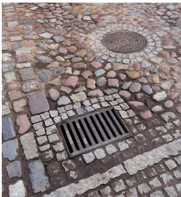
Ryc. 6. Ulica Tylne Chwaliszewo – kontakt kostki rzędowej z „koci- mi łbami” i zniszczone krawężniki diorytowe
