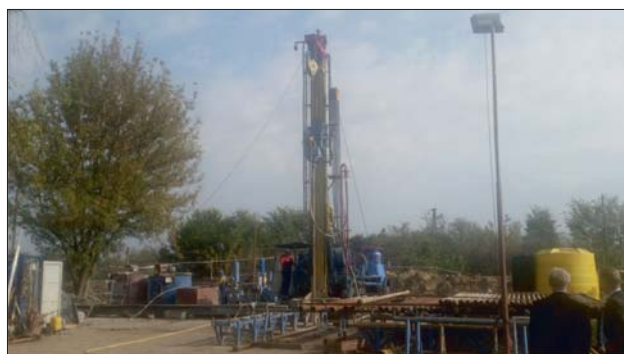
Ryc. 3. Wykonywanie otworu wiertniczego Cudzynowice GT-1, w którym udokumentowano duże zasoby termalnych wód leczniczych. Fot. M. Kos
