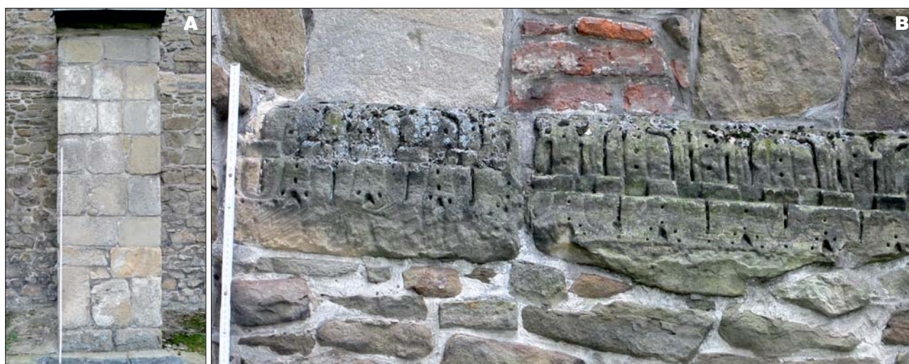
Ryc. 5. Gotycki kościół w Czchowie. A – przypora zbudowana z piaskowcowych ciosów kościoła romańskiego, B – romański fryz Fig. 5. Gothic church in Czchów. A – butress constructed of blocks of the Romanesque church, B – Romanesque frieze
