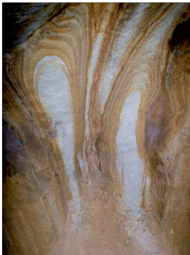
Ryc. 2. Zjawiska wietrzeniowe na ociosie obiektu Gontowa. Fot. M. Stysz
