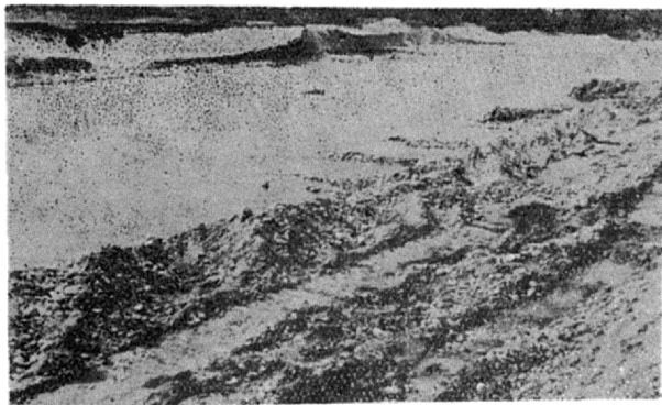
Ryc. 1. Końcowe stadium eksploatacji żwiru na Czarnym Dunajcu, na N od Chochółowa (1961 r.). Widać ślady koparki, po lewej hałda materiału zgarniętego z dna rzeki.
