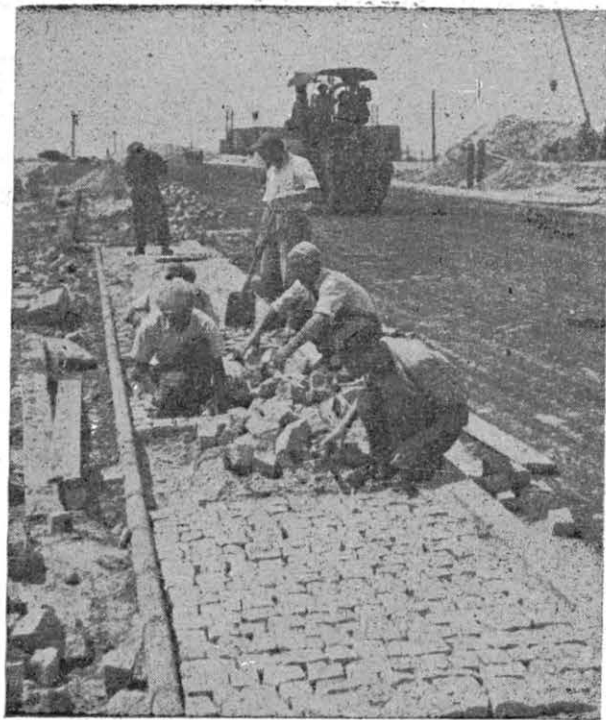
Budowa nawierzchni kostkowej (fot. CAF)
