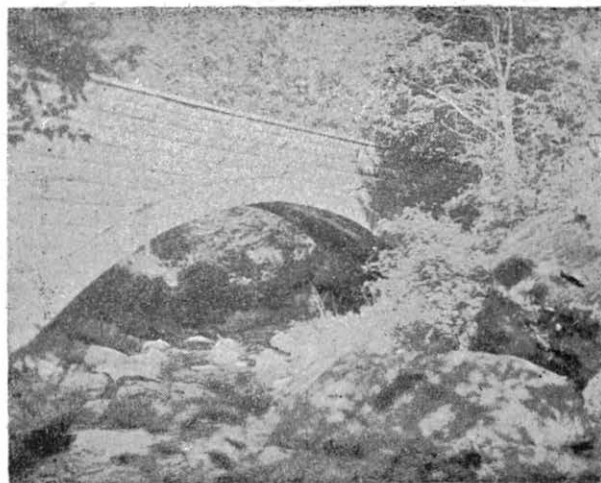
Kamień ciosowy w budownictwie mostów. (fot. T. Burakowski)
