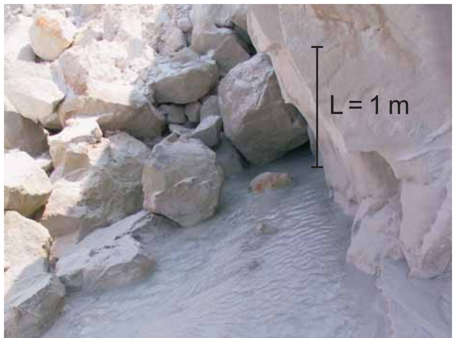
Ryc. 5. Kawerna we wschodniej skarpi odkrywkę (wypływ wód na spąg wyrobiska)
