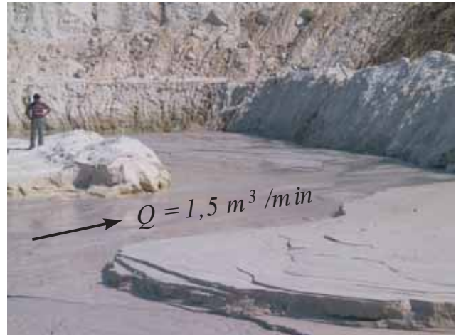
Ryc. 4. Ciek powierzchniowy odprowadzający wody, wypływające na spąg wyrobiska (rejon wschodniej skarpy)
