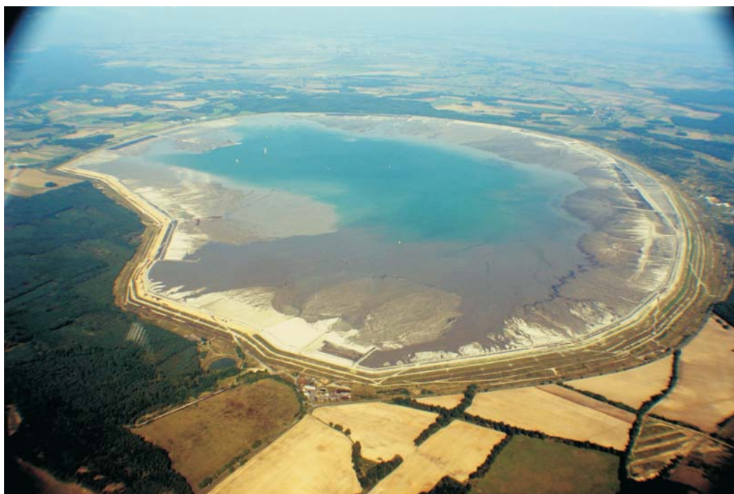
Ryc. 3. Zakład Hydrotechniczny KGHM Polska Miedź SA — zbiornik osadowy Żelazny Most . Fot. ze zbiorów Muzeum Ziemi Lubińskiej
