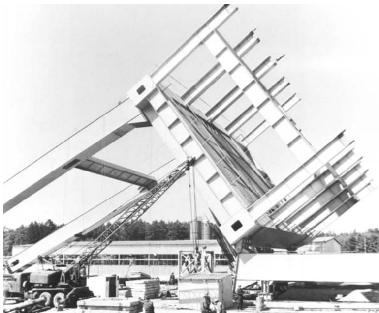
Ryc. 3. Pierwsza faza podnoszenia wieży szybu R-I kopalni Rudna
