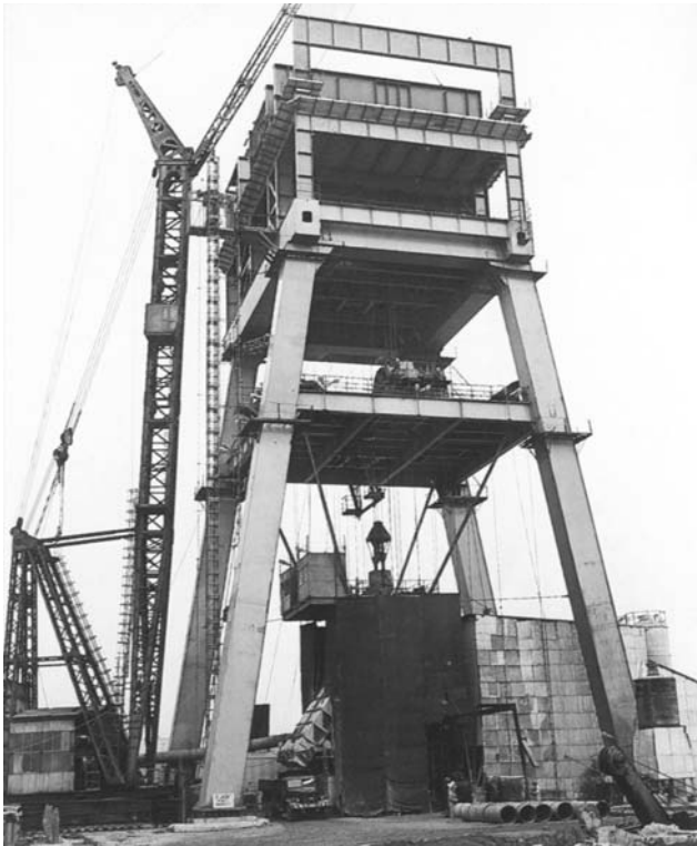
Ryc. 4. Montaż wieży szybowej w Rudnej. Wszystkie fot. ze zbiorów KGHM Polska Miedź SA
