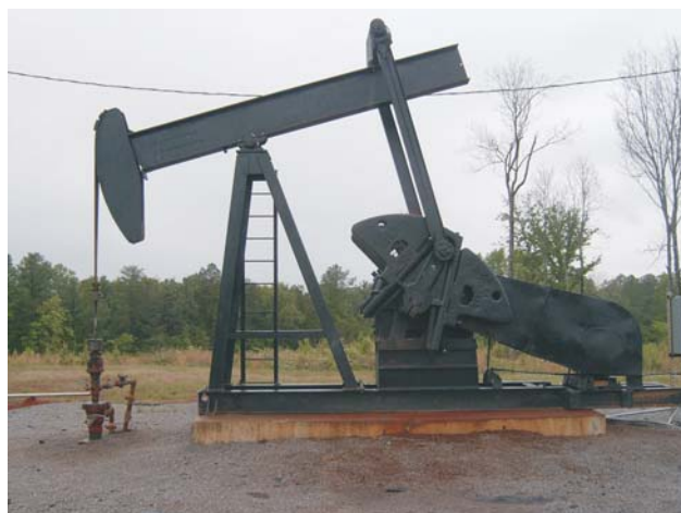
Ryc. 5. Pompa żerdziowa odpompowująca wody złożowe w celu osuszenia pokładów węgla i stworzenia warunków do eksploatacji metanu — pole Brookwood (Zagłębie Black Warrior, Alabama). Fot. M. Młynarczyk
