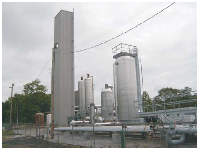
Ryc. 4. Instalacja wzbogacająca gaz w metan — pole Brookwood (Zagłębie Black Warrior, Alabama). Fot. M. Młynarczyk
