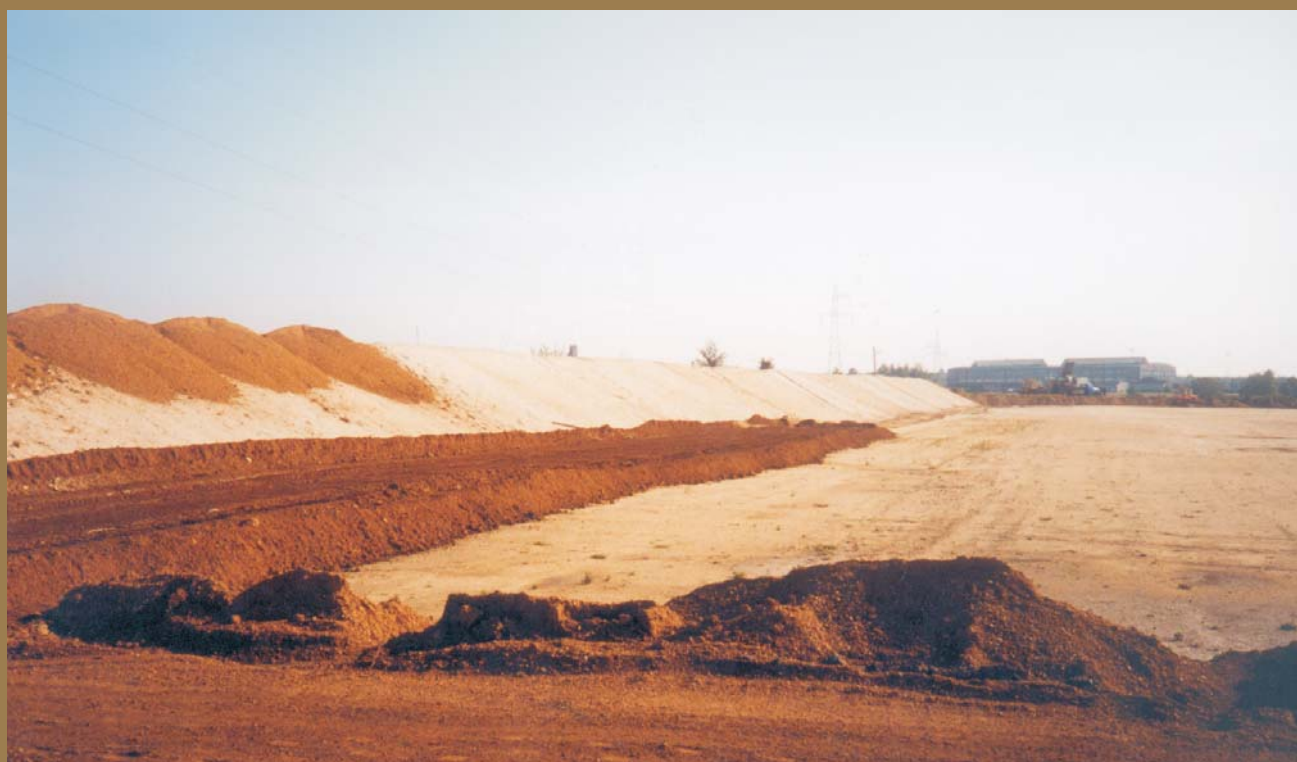
Ryc. 3. Budowa składowiska odpadów niebezpiecznych w Tamowskich Górach. Formowanie geologicznej warstwy izolacyjnej; fot. A. Dragowski
