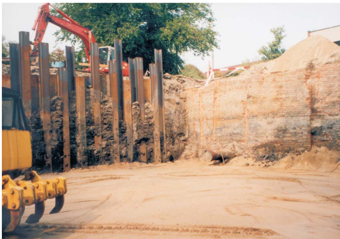
Polepszenie właściwości podłoża budowlanego poprzez wymianę gruntów antropogenicznych; Warszawa, ul. Karowa; fot. A. Drągowski
