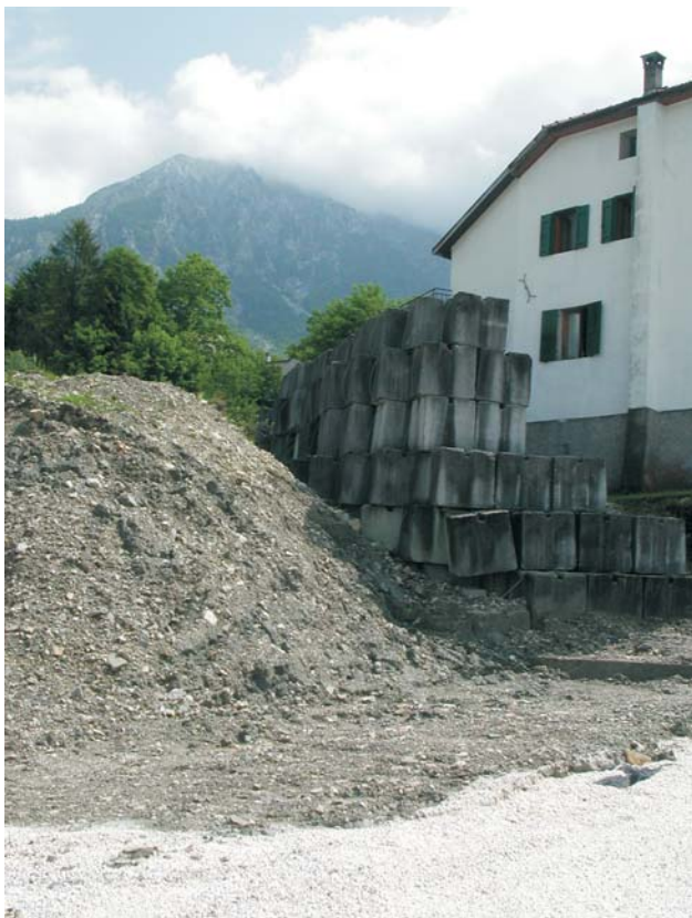
Ryc. 3. Mur zabezpieczający osuwisko w Tessinie w rejonie wioski Funes
