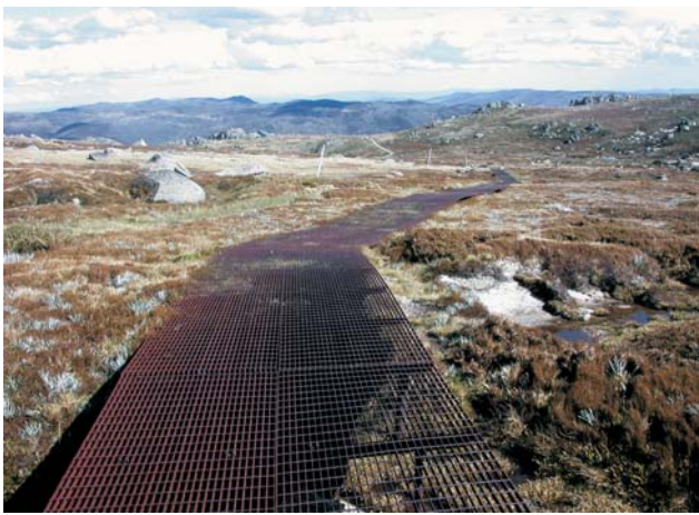
Ryc. 4. Wiodąca na Górę Kościuszki metalowa ścieżka, ustawiona w celu ochrony alpejskiej roślinności przed zadeptywaniem
