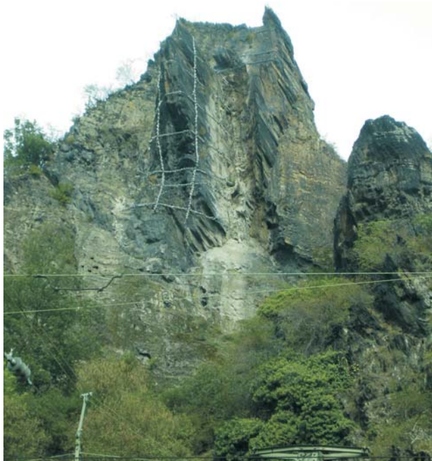
Ryc. 3. Widok na zabezpieczony blok skalny — St. Goarshausen. Fot. L. Leoni
