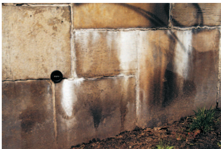
Ryc. 4. Redepozycja węglańu wapnia wymytego ze spoin i zaprawy murarskiej. Pomnik papieża Jana XIII z 1968 r.
