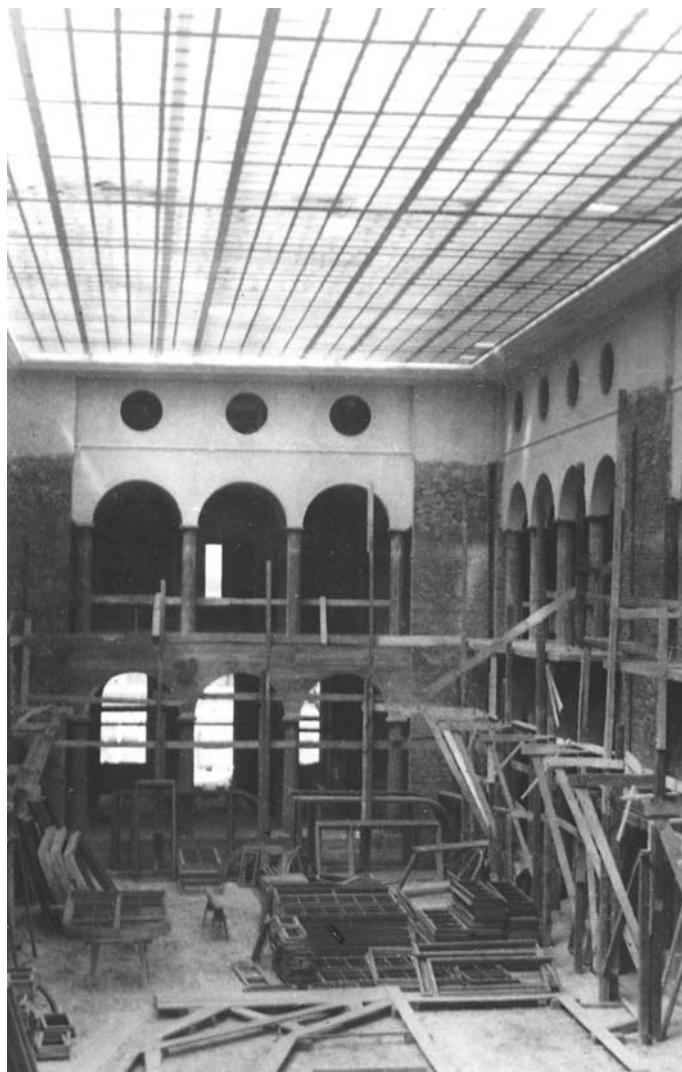
Ryc. 1. Sala Muzeum Geologicznego PIG w trakcie budowy (koniec lat 20. XX w.). Arch. Sekcji Historycznej PIG
