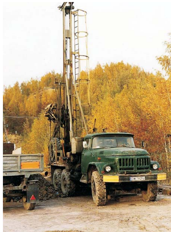
Ryc. 9. Przewoźne urządzenie wiertnicze. Arch. PG Wrocław
