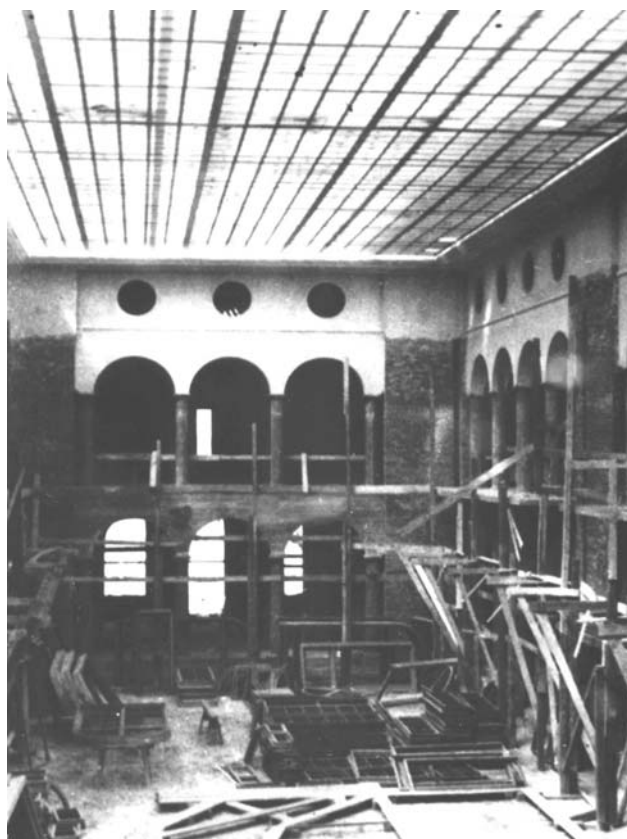
Ryc. 4. Budowa gmachu PIG, lata 30. XX w.
