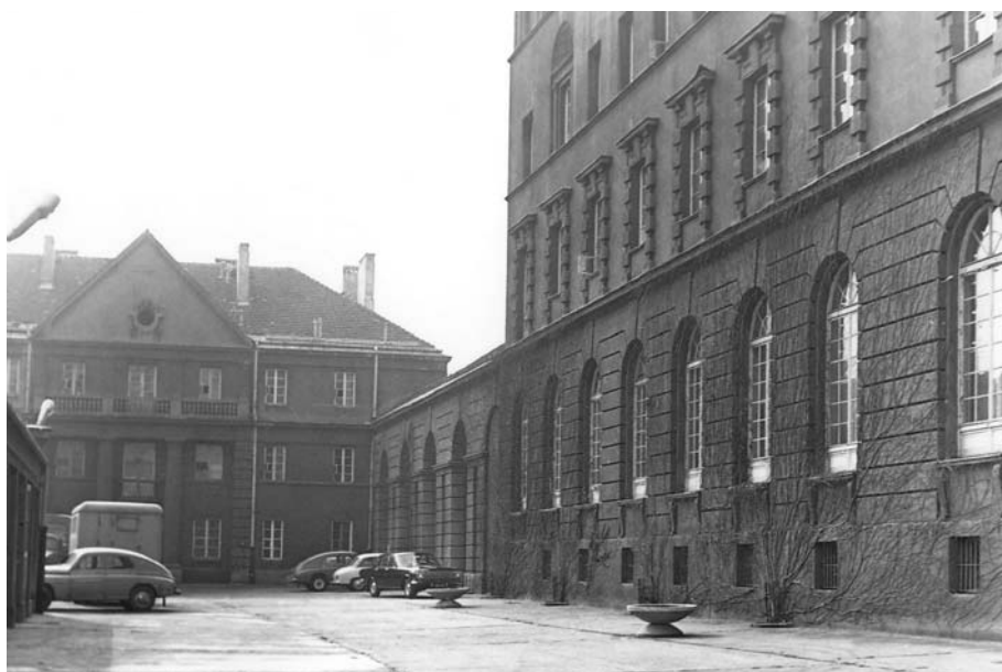
Ryc. 9. Fragmenty elewacji gmachów PIG (lata 60. XX w.)
