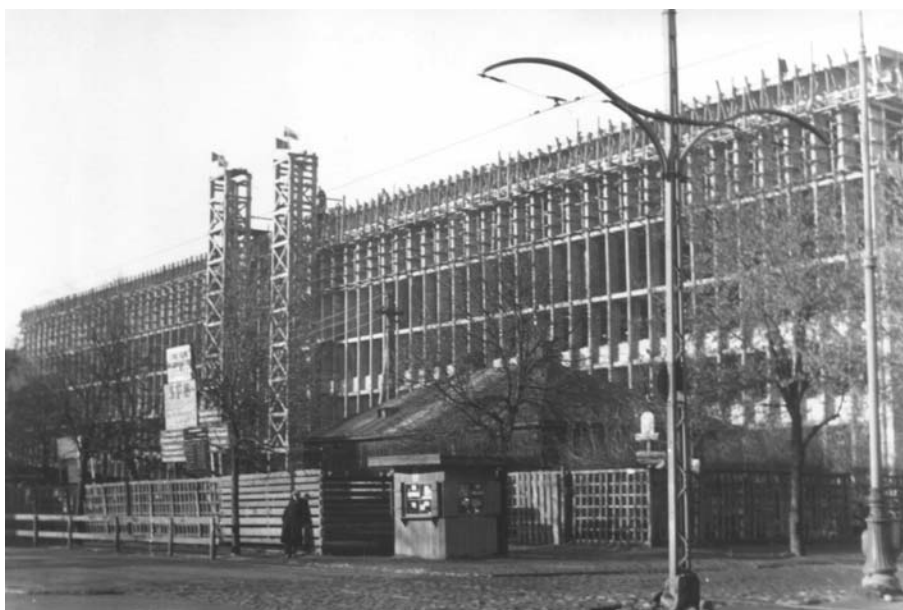
Ryc. 8. Budowa nowego gmachu PIG przy ul. Rakowieckiej (początek lat 50. XX w.)
