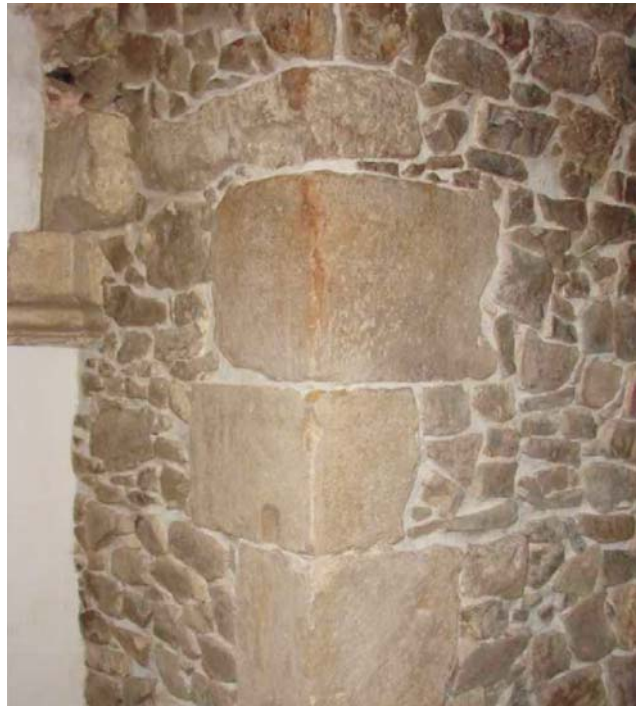
Ryc. 10. Ściana krużganku wykonana z nieregularnych kształtek piaskowca kunowskiego, a naroża z bloków tego piaskowca
