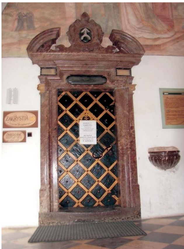
Ryc. 6. Portal wejściowy do zakrystii wykonany ze zlepińca cechsztyńskiego
