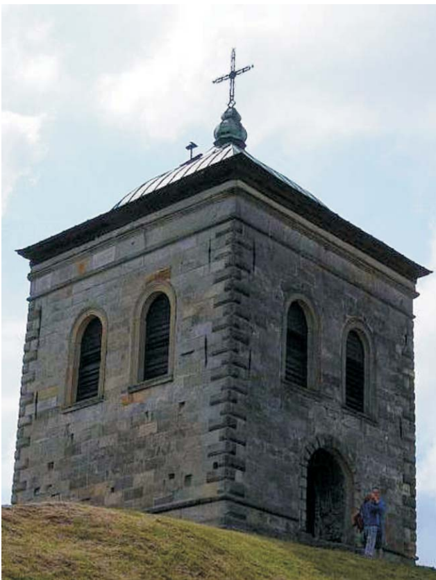
Ryc. 11. Dzwonnica zbudowana z bloków piaskowca liasowego (widok od strony wschodniej)
