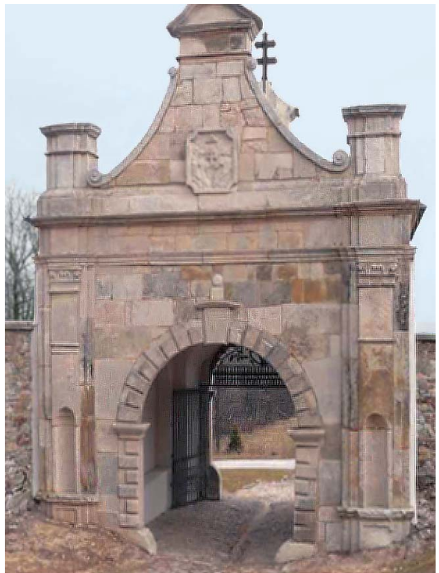
Ryc. 12. Brama wjazdowa we wschodniej części muru wykonana z piaskowca liasowego
