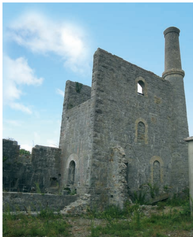
Ryc. 1. Budynek nieczynnej maszynowni na terenie kopalni cynku i ołowiu w Shallee (rejon Silvermine, Irlandia). Fot. I. Bojakowska
