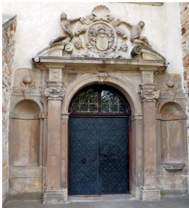
Ryc. 6. Piaskowiec w detalach architektonicznych zamku
