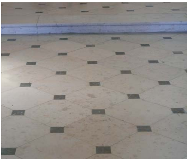
Ryc. 17. Posadzka w kaplicy pałacowej ułożona z jasnego jurajskiego wapienia plamkowego i ciemnobrązowego wapienia dewońskiego
