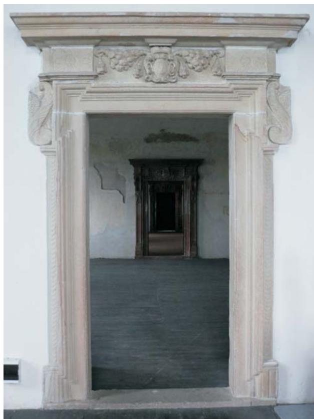
Ryc. 13. Portal na II piętrze zamku wykonany z piaskowca istebniańskiego ze złoża Sobolów
