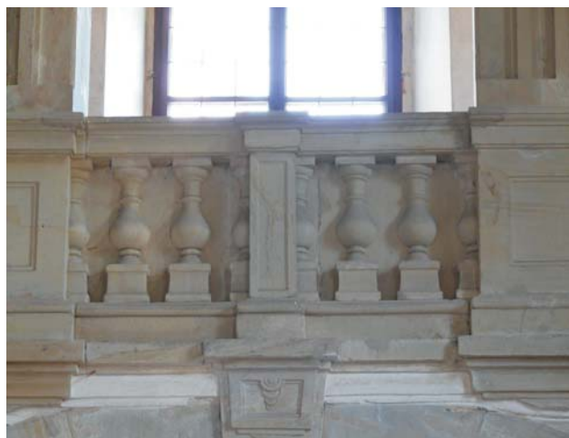
Ryc. 15. Tralki na pierwszym piętrze kaplicy wykonane z piaskowca kredowego z Dolnego Śląska. Ryc. 12–15 fot. P. Ozga
