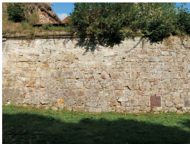
Ryc. 3. Bloki i kształtki piaskowca istebniańskiego w kurtynie południowo-wschodniej
