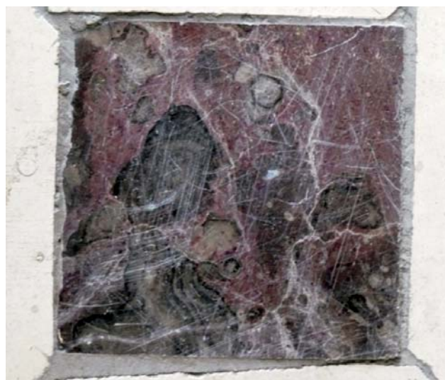
Ryc. 18. Element posadzki w kaplicy wykonany z wapienia dewońskiego, który uległ zmatowieniu i porysowaniu. Ryc. 16–18 fot. P. Ozga
