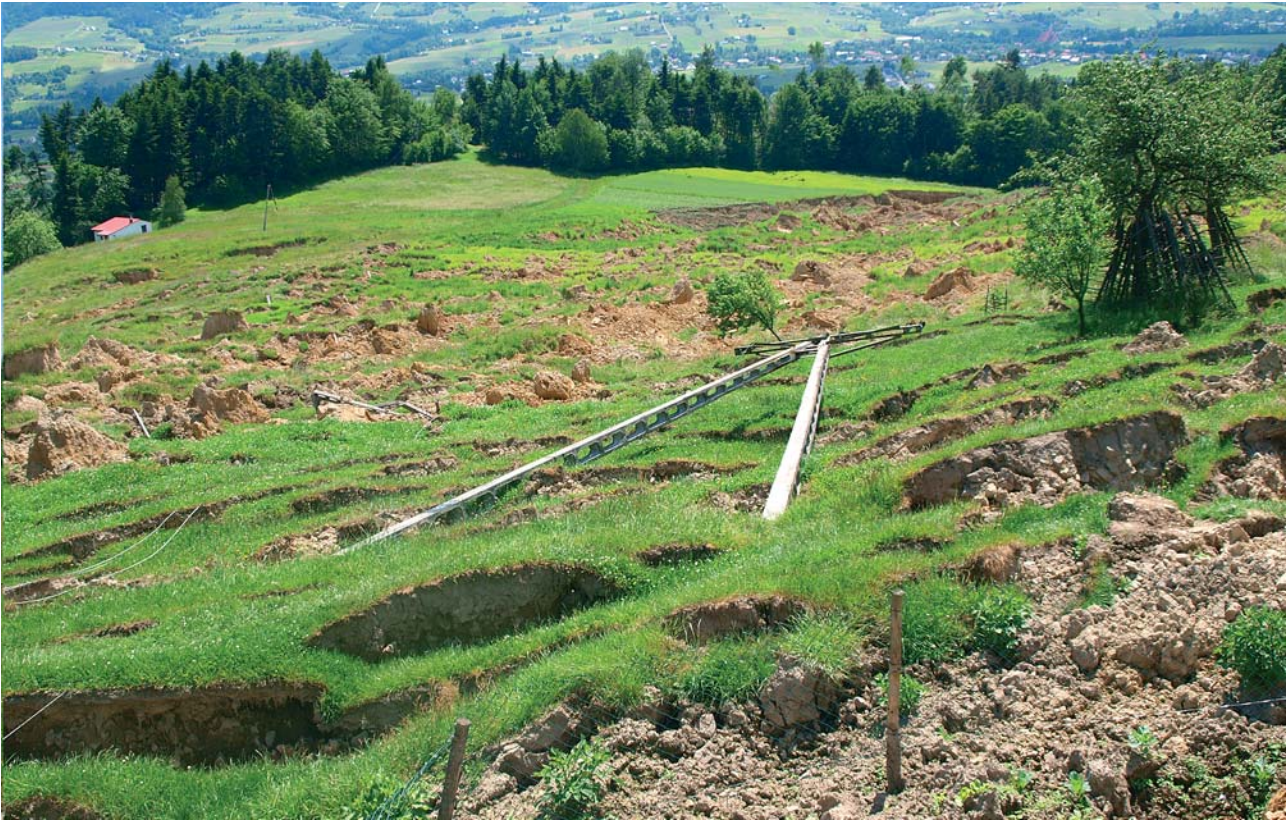
Ryc. 1. Widok na osuwisko, Kłodne k. Limanowej, Kapaty, Beskid Wyspowy
