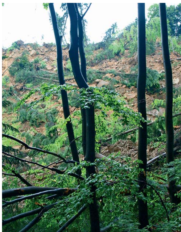
Ryc. 3. Widok na zniszczony las w odnowionej części osuwiska, Kłodne k. Limanowej. Wszystkie fot. A. Wójcik
