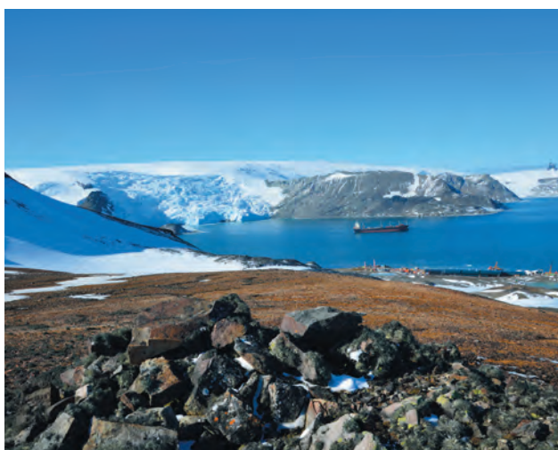
Ryc. 5. Brazylijska Stacja Antarktyczna Comandante Ferraz w Zatoce Martel (północno-wschodnia część Zatoki Admiralicji; w budowie) Fig. 5. Comandante Ferraz Brazilian Antarctic Station in the Martel Inlet (NE part of Admiralty Bay)
