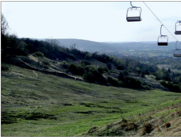
Ryc. 9. Osuwisko na stoku narciarskim w Przemysłu Fig. 9. The landslide on the ski slope in Przemysł
