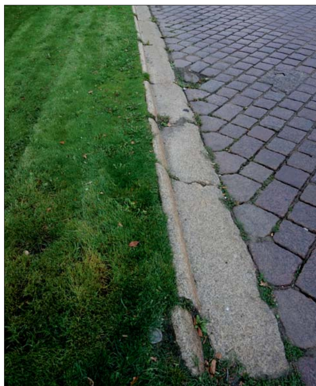
Ryc. 2. Aleje Marcinkowskiego, jezdnia wschodnia między ul. 23 Lutego a ul. Paderewskiego – granitowe rynsztoki, wzdłuż nich kostka w kształcie tzw. czapek biskupich i ułożenie kostki w „jaskółczy ogon”. Wszystkie fotografie J. Skoczylas
