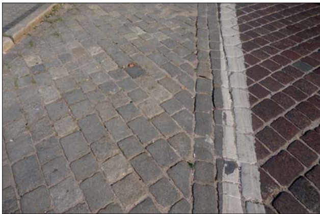
Ryc. 3. Aleje Marcinkowskiego, jezdnia wschodnia w miejscu rozszerzenia przy Muzeum Narodowym – bruk z szarych kostek granitu, gnejsu i kwarcytu
