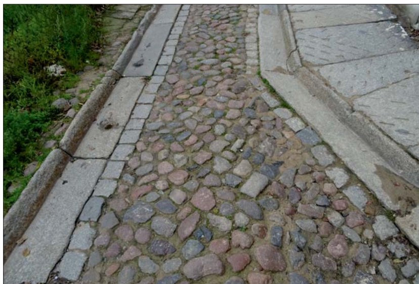
Ryc. 7. Ulica Wysoka – bruk z nieobrobionych narzutniaków i unikalne elementy sztuki brukarskiej – płyty chodnikowe z reliefem antypoślizgowym
