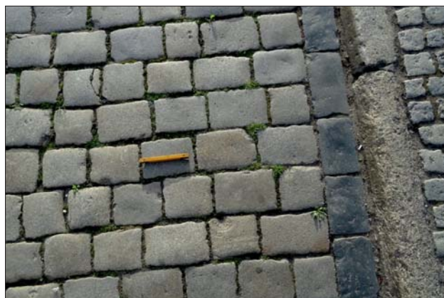
Ryc. 8. Ulica Paderewskiego – kostka granitowa, pas kostki bazaltowej, granitowe krawężniki, drobna kostka na chodniku, głównie kwarcytowa
