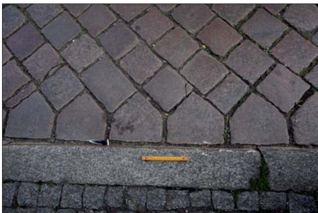
Ryc. 4. Ulica 23 Lutego – „czapki biskupie” przy krawężniku z szarego granitu i bruk ułożony w „jaskółczy ogon”
