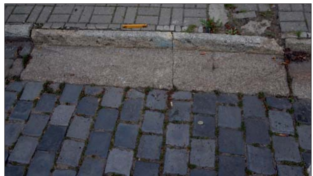
Ryc. 6. Ulica Młyńska między ul. F. Nowowiejskiego a pl. Ratajskiego – kostka brukowa z tzw. leizny bazaltowej, granitowe rynsztoki oraz współczesna kostka chodnikowa
