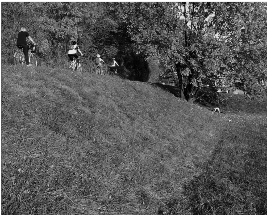
Ryc. 2. Wał przeciwpowodziowy w Krakowie. Skarpa nasypu, która nie jest zalewana wodami od góry. Wody opadowe spływające po skarpie jej nie erodują – nie są widoczne jakiegokolwiek bruzdy erozyjne, pomimo że nasyp jest stary (kilkadziesiąt lat). Fot. B. Rzonca
