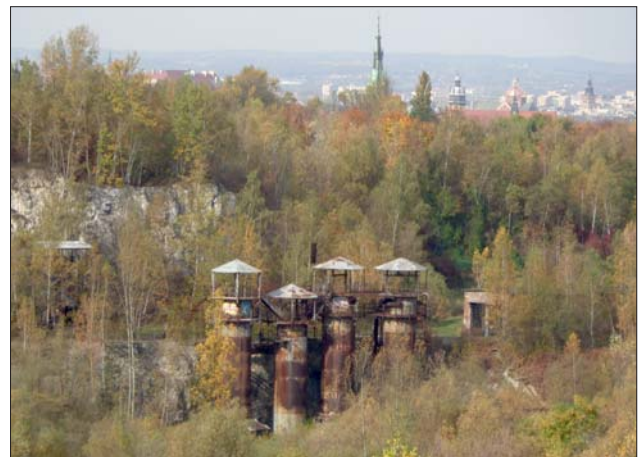
Ryc. 18. Pozostałości zabudowy przemysłowej w kamieniołomie Liban, na dalszym planie Stare Miasto (19.10.2019)
