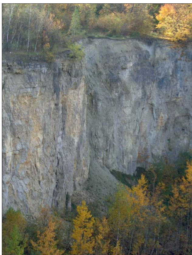
Ryc. 15. Stożek usypiskowy w kamieniołomie Liban (19.10.2019) Fig. 15. Debris cone in the Liban quarry (19.10.2019)
