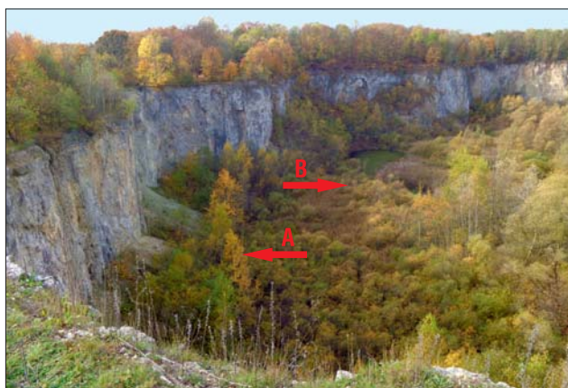
Ryc. 14. Ściana południowa i południowo-zachodnia kamieniołomu Liban. A – stożki usypiskowe; B – zbiorniki wodne (19.10.2019) Fig. 14. The southern and south-western wall of the Liban quarry. A – debris cones, B – water reservoirs (19.10.2019)
