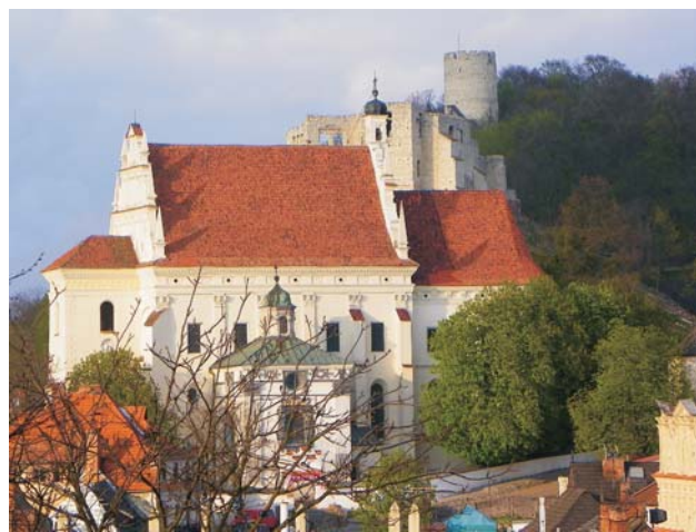
Ryc. 8. Kościół farny, zamek i baszta w Kazimierzu Dolnym zbudowane są z mastrychckiej opoki kazimierskiej. Fot. J. Warowna Fig. 8. Parish church, castle and tower in the town of Kazimierz Dolny were built from the so-called Kazimierz opoka originating from the Maastrichtian stage. Photo by J. Warowna
