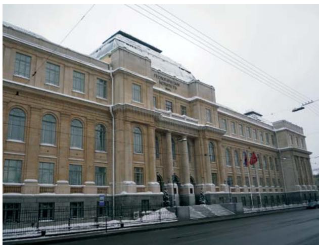
Ryc. 6. Gmach Komitetu Geologicznego przemianowanego na Rosyjski Geologiczny Instytut Badawczy (VSEGEI) wybudowany na Prospekcie Średnim na Wyspie Wasilewskiej w 1914 r. – stan obecny
