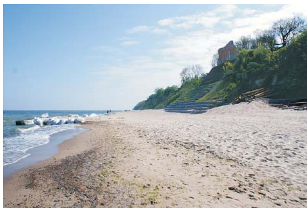
Ryc. 11. Południowa ściana kościoła w Trzęsaczu. Fot. R. Dobracki
