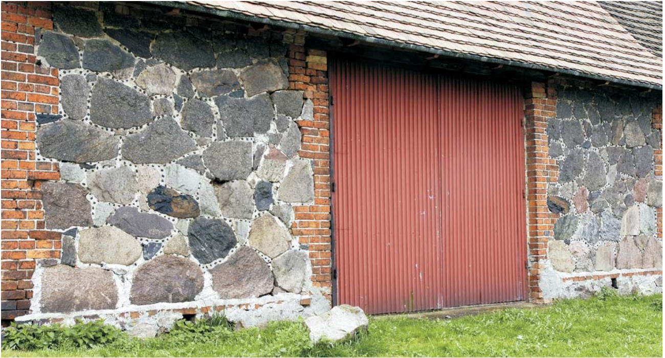
Ryc. 9. Zdobienia budynków gospodarczych głazami narzutowymi i szlaką z pieców huty szkła. Fragment ściany stodoły z XX wieku w Trzebielu
