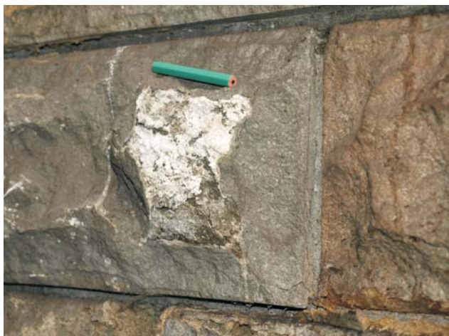
Ryc. 3. Wykwit podpowierzchniowy soli krystalizujących na piaskowcowej okładzinie wyjścia zachodniego pod szklanym sufitem przejścia południowego. Sytuacja z chwili po zdjęciu przykrywającego wykwity powierzchniowego płata piaskowca. Stan z początku maja 2010 r. Długość ołówka – 6 cm
