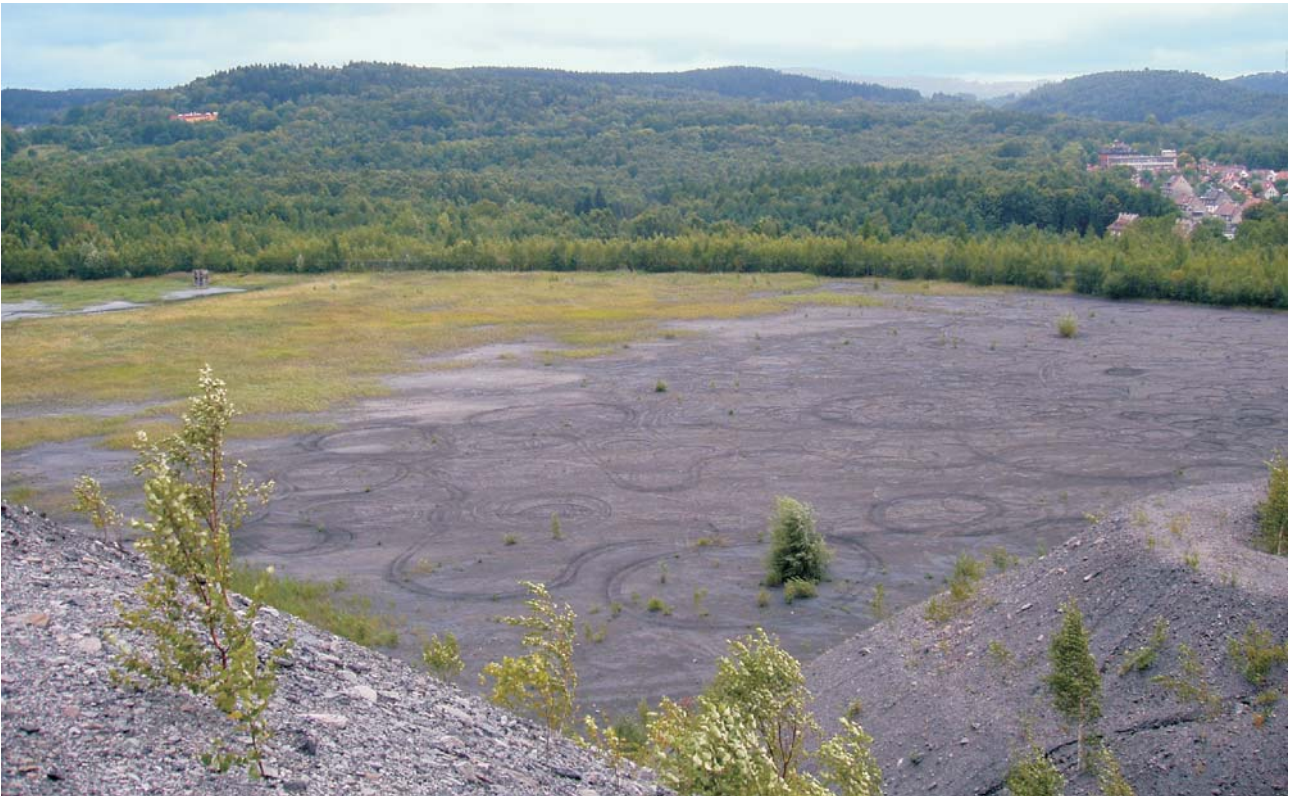
Ryc. 4. Część nieczynnego osadnika 17-1 z osadami poflotacyjnymi w Wałbrzychu Śródmieściu Fig. 4. The part of the inactive settling pond (17-1) with post-flotation wastes in Wałbrzych Śródmieście
