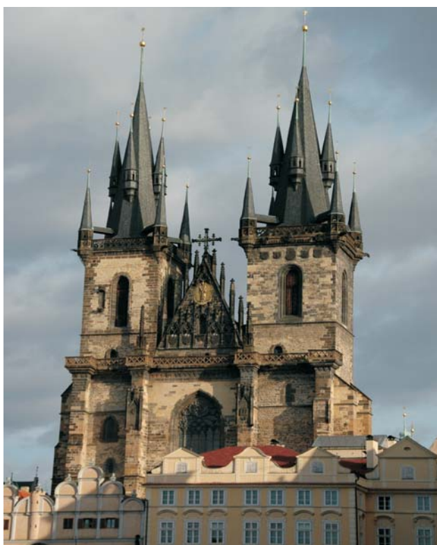
Ryc. 2. Kościół Najświętszej Marii Panny przed Tynem zbudowany z „opuki”. Fot. J. Byliniak-Kozłowska
