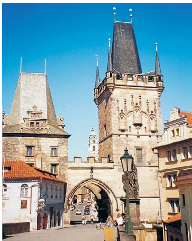
Ryc. 3. Dwie Malostranské věže na zachodnim końcu mostu. Zbudowane głównie z piaskowca arkozowego i „opuki”, dach wykonany z fylłitu. Niższa z XII w., wyższa z XV w. Fot. A. Kozłowska
