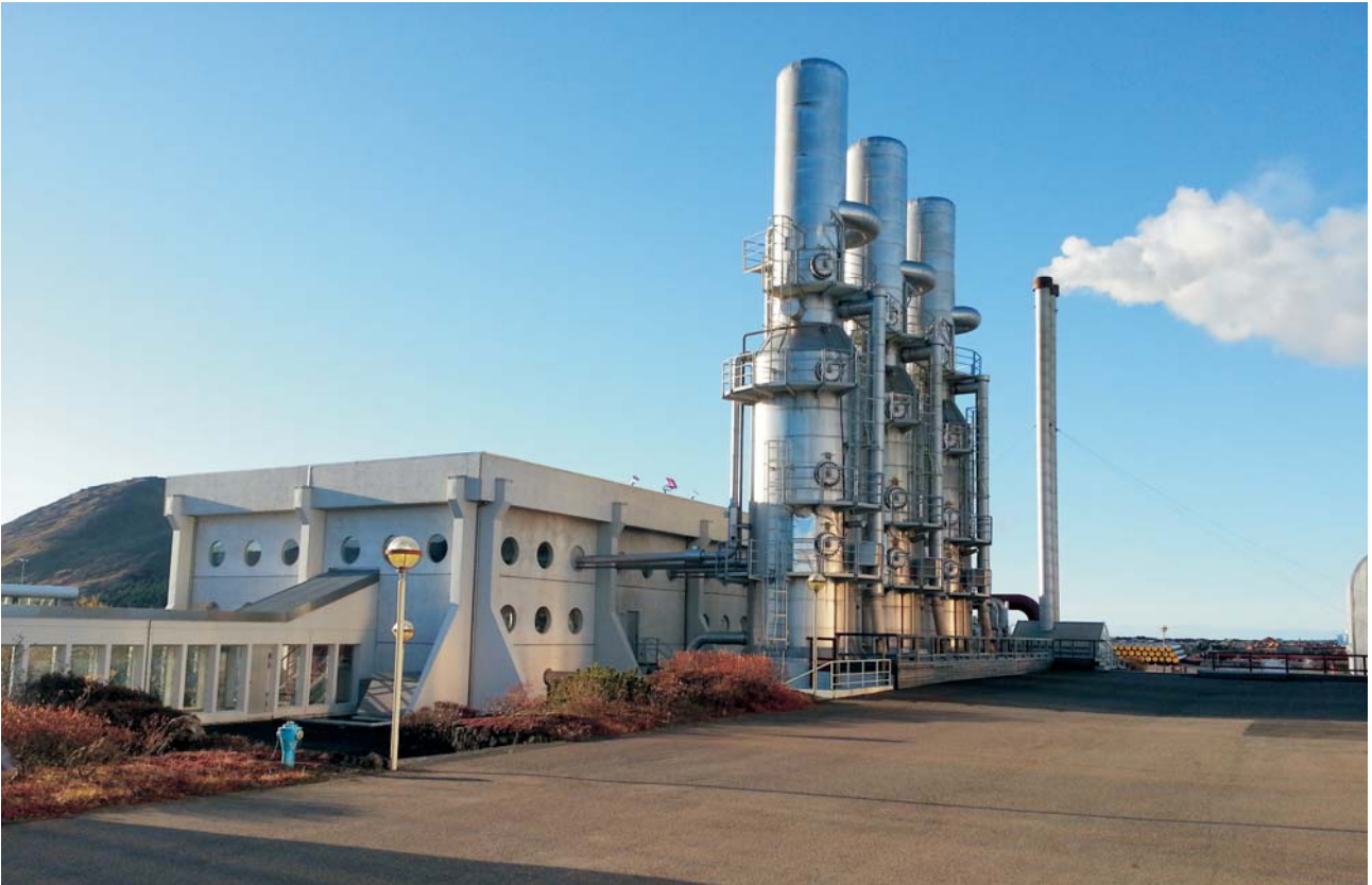
Ryc. 3. Siłownia geotermalna Svartsengi (Islandia) wykorzystująca oprócz klasycznej turbiny na parę geotermalną obieg ORC Fig. 3. Geothermal power plant Svartsengi (Iceland) utilizing ORC cycle in addition to the classical steam turbines
