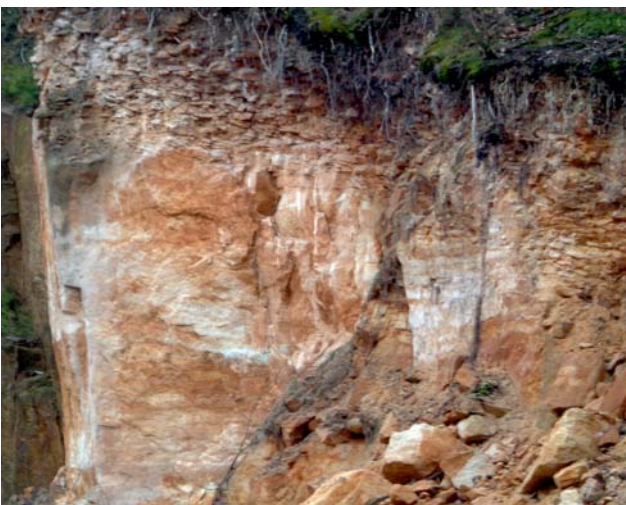
Ryc. 5. Strop warstwy piaskowcowej w ścianie nieczynnego kamieniołomu
