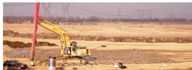
Ryc. 3. Wykonywanie drenażu pionowego. Fot. E. Majer
