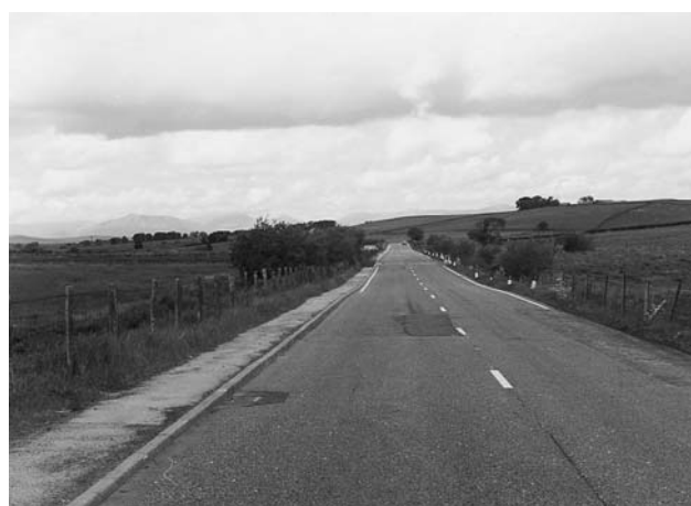
Ryc. 6. Nawierzchnia drogi A5 w Północnej Walii wybudowanej na gruntach organicznych (Nichol & Farmer, 1998)
