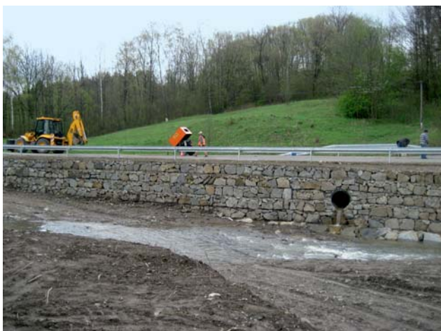
Ryc. 16. Stabilizacja osuwiska w Sękowej Fig. 16. Sękowa landslide stabilization
