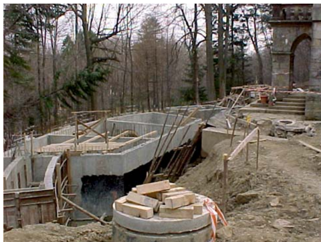
Ryc. 19. Stabilizacja osuwiska koło kaplicy św. Jana z Dukli Fig. 19. Stabilization of landslide near St. John of Dukla Chapel
