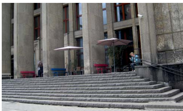
Ryc. 8. Schody wejściowe do gmachu Muzeum Narodowego przy al. 3 Maja w Krakowie wykonane z klesowitu wołyńskiego o fakturze groszkowej
