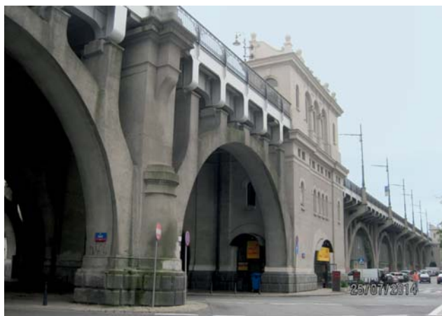
Ryc. 11. Wiadukt mostu księcia Józefa Poniatowskiego przy ulicy Solec w Warszawie z cokołem z „sjenitu” zdziłowskiego
