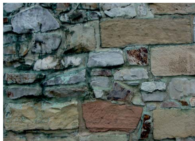
Ryc. 7. „Dziki mur” zbudowany z kambryjskich, triasowych i jurajskich piaskowców w podmurówce dzwonnicy. Ryc. 6, 7 fot. D. Szrek
