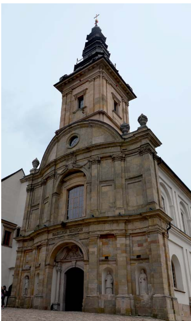
Ryc. 9. Główna, zachodnia fasada klasztoru z nowo odbudowaną wieżą Fig. 9. Main, western facade of the monastery with newly rebuilt tower
