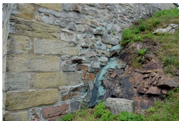
Ryc. 6. Fundamenty dzwonnicy na wychodni kambryjskich piaskowców
